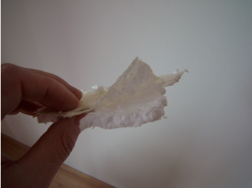
Bild 2 Zwischen der EPS-Dämmung und der Folie hatte sich eine Art Folie gebildet
