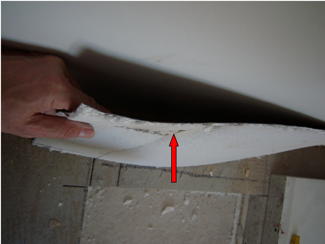
Bild 3 Wegschrumpfen der EPS-Dämmung bis auf Null
