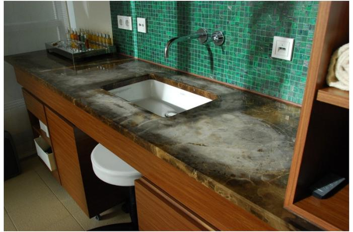
Bei diesem Waschtisch wurde ein Reinigungsmittel mit Säurezusatz verwendet. Das Reinigungsmittel ist für das Entfernen von Kalk (Kalkentferner) ausgelegt. Um diese Aufgaben gerecht zu werden, enthalten diese Reinigungsmittel Salzsäure. Diese Säure greift Marmor und Kalkstein an, da diese Gesteine ebenfalls aus reinem Kalk (95%) bestehen.
