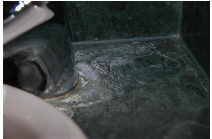
Um die Armaturen zu reinigen, wurde ein Armaturenreiniger verwendet. In diesem Reinigungsmittel ist Phosphorsäure enthalten. Phosphorsäure ist eine sehr aggressive Säure und greifen nahezu alle Natursteine an. Die bräunliche Verfärbung zw. Armatur und Stein wurde deshalb verursacht, da Phosphorsäure die Eisenverbindungen im Stein knackt. Das „freie Eisen“ wird mit Sauerstoff zu Rost umgewandelt.
